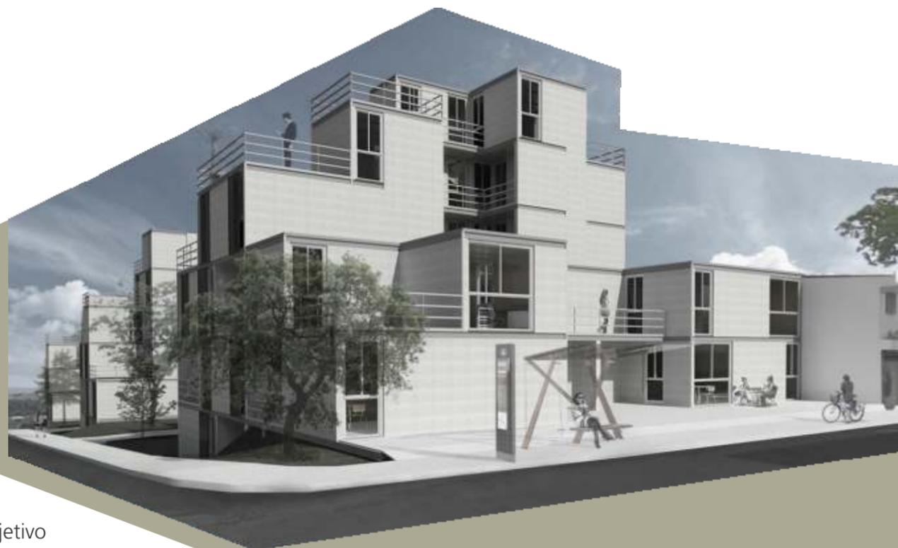
Com duas fases, o projeto tem por objetivo desenvolver, em primeiro lugar, um sistema construtivo modular para habitações com base no uso da madeira como matéria-prima. Todas as peças, executadas em CLT, foram desenhadas para facilitar e agilizar a montagem e o manuseio do sistema.
